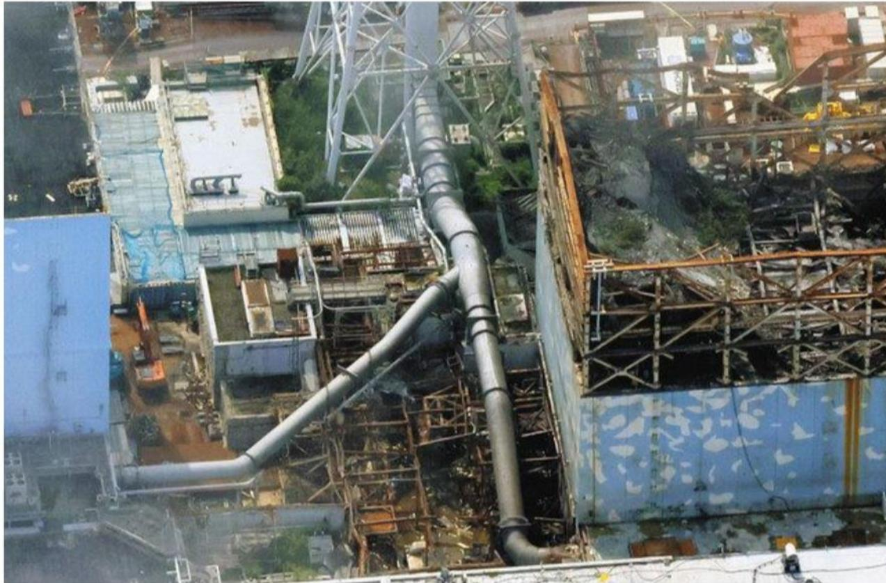
福島第一原発の1号機(右)と2号機間にある太い配管に沿うように設置された細い配管の切断撤去は、2号機側の一部しかできず中断。東電は周辺のがれき撤去を先行させる
